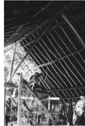
Fig. Tigitgiy no-yot, installer le toit de chaume.
